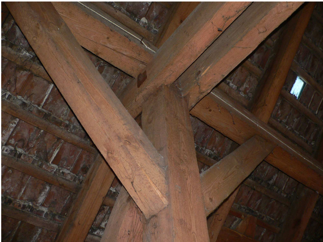
Ryc.2 Istniejąca więźba dachowa.
