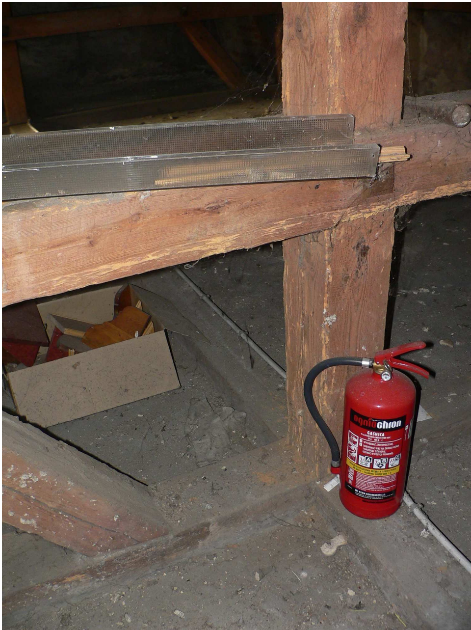
Ryc. 3 Istniejące podwaliny.
