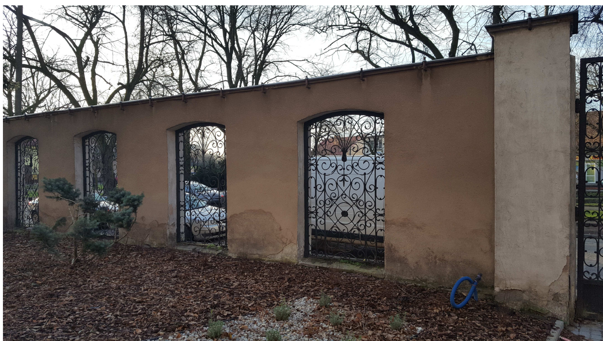
Zał. 4. Mur przeznaczony do remontu
