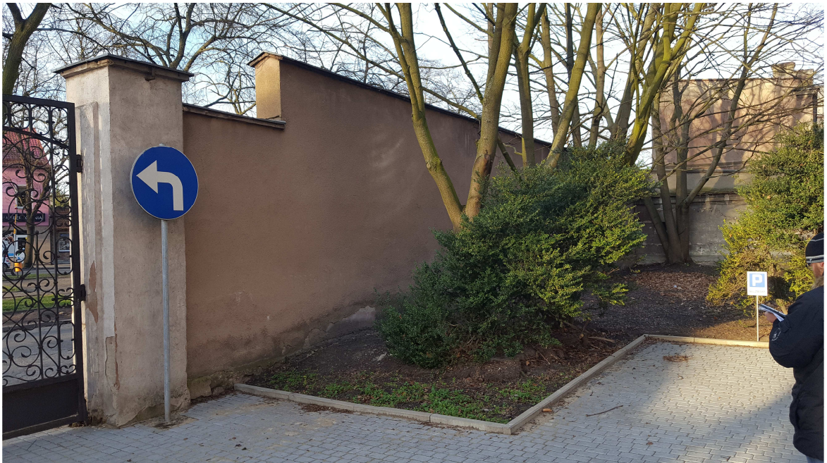
Zał. 5. Mur przeznaczony do remontu
