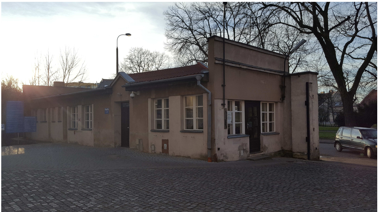
Zał. 6. Portiernia przeznaczona do remontu
